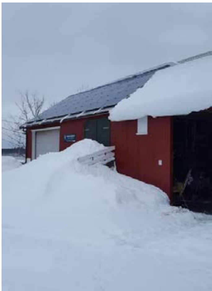
Figur 23: GLASS – GLASS PANELER FUNGERER FINT FOR FJERNING AV SNØ.
