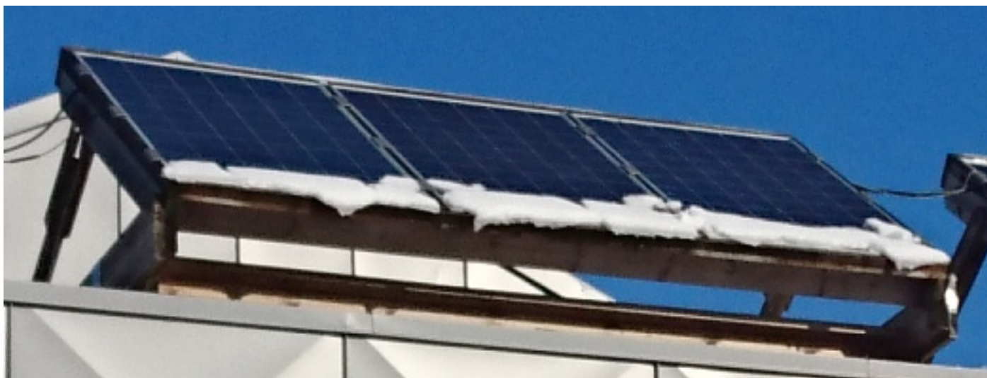
Bilde 4: Snø nederst på solcellemodulene vil i dette tilfellet sannsynligvis redusere produksjonen betraktelig eller kanskje fullstendig
