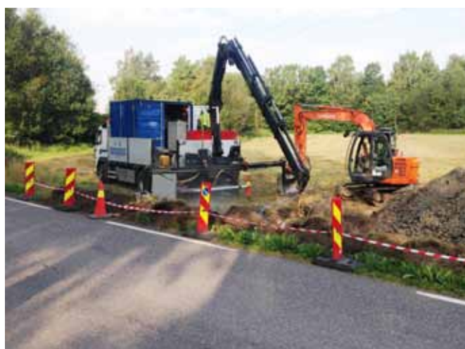
VA-sanering med styrt boring.
