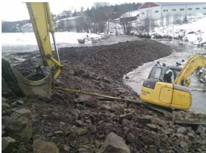
Steinsetting og erosjonssikring.
