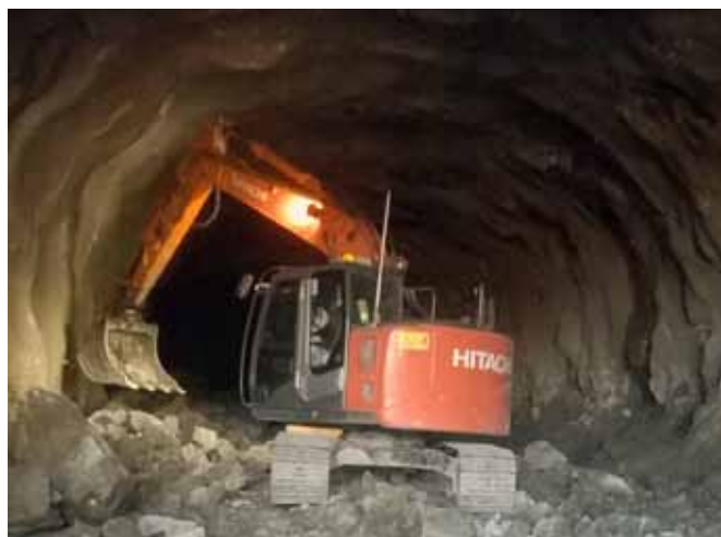
15 tonns graver med GPS i tunnelrehabilitering.
